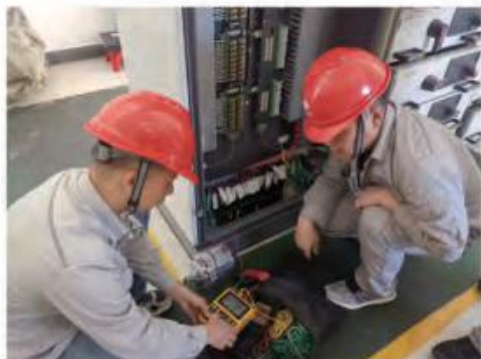
惠州公司#2机组DCS改造调试
