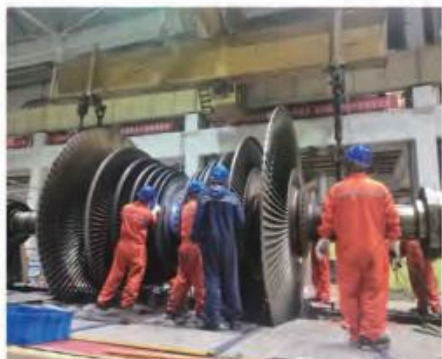
马鞍山#4A修监管现场
